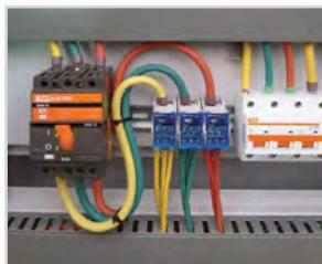
Большое количество точек подключения с возможностью использования как проводников с наконечниками, так и без них, с возможностью визуальной проверки присоединения кабеля.
