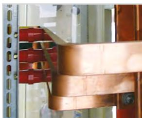
Изоляторы SM используются при сборке НКУ различного назначения.
