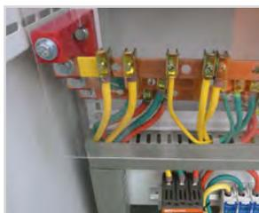
Изоляторы шинные «Лесенка» используются при сборке НКУ различного назначения.
